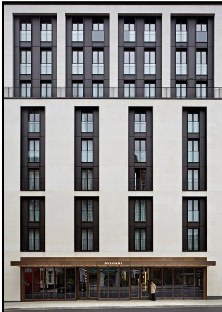
Façade organisée selon le style colonial (soubassement, corps de la façade, couronnement)
