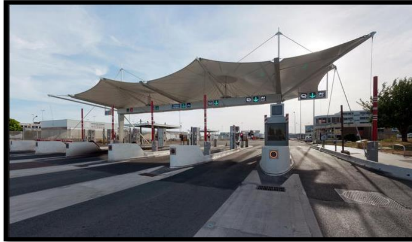
Figure 79: exemple de structure tendue 101
