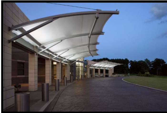
Figure 80: exemple de structure tendue lier au bâtiment
