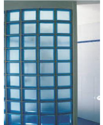
Fig102. Exemple cloison de panneaux de verre
