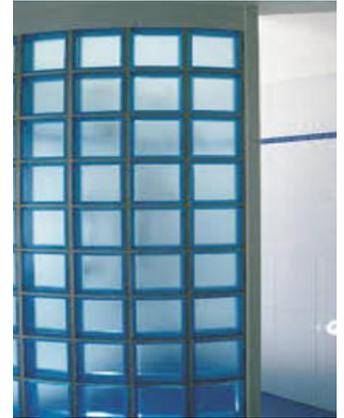
**Fig102. Exemple cloison de panneaux de verre**
