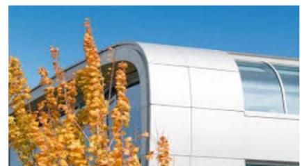
**Fig91. Exemple d'un toit en ALM brossé<sup>3</sup>**
