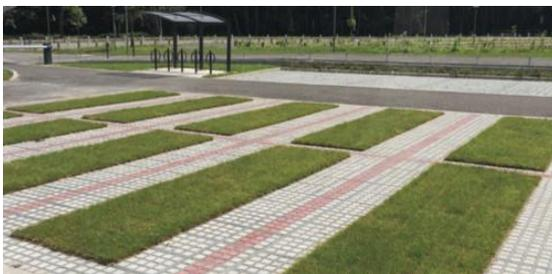
**Fig.04.** Bandes gazonnées d'infiltration <sup>(3)</sup>
