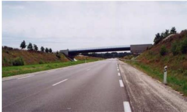
Photo 2-6 Exemple de situation non lisible, Difficulté pour comprendre sur quel type de voie on se situe
