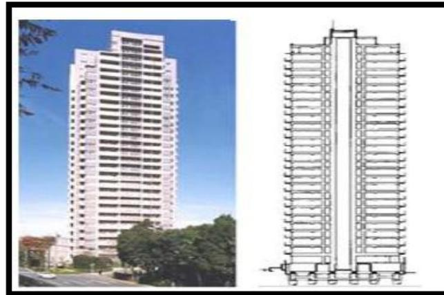
Figure IX.5. Application du système d'isolation japonaise aux gratte-ciels [23].
