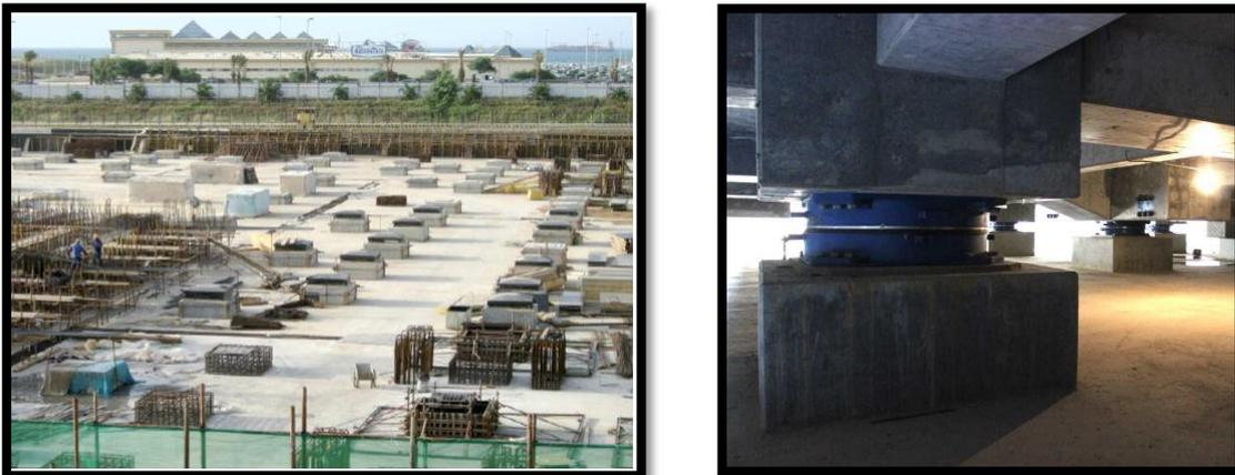
Figure IX.9. Isolation sismique sous la grande mosquée d'Alger [17].
