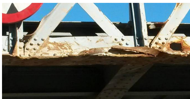
photo.4.11 Membrane inferieure et contreventements de la poutre principale vers Sebdu
