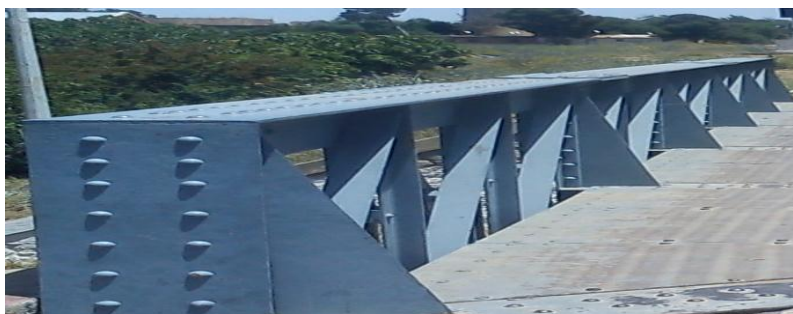
Photo.4.9 Poutre principale vue d'en haut
