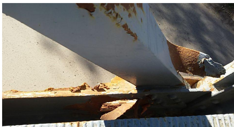
Photo.4.12 Barre de contreventement du panneau 05 en allant vers la gauche (coté Sebdu)
