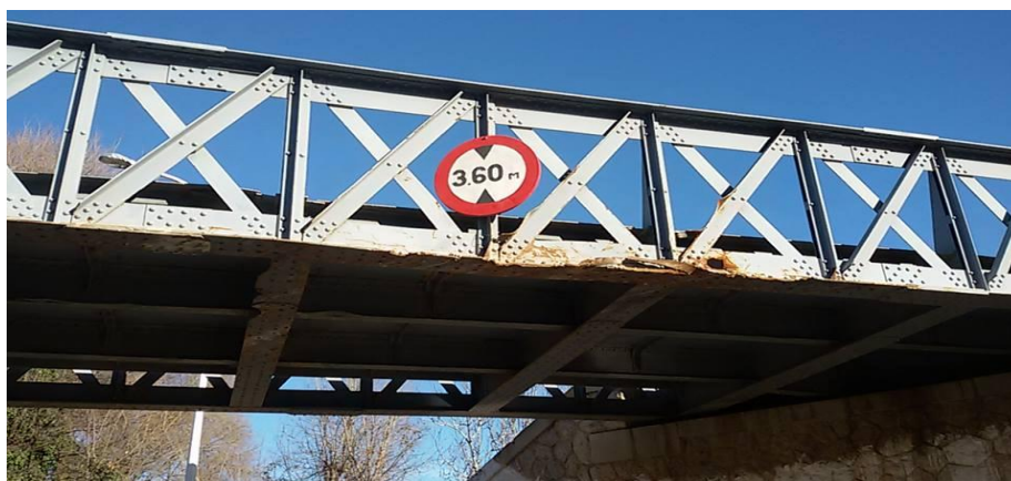
Photo.4.4 Poutre principale vers Sebdou
