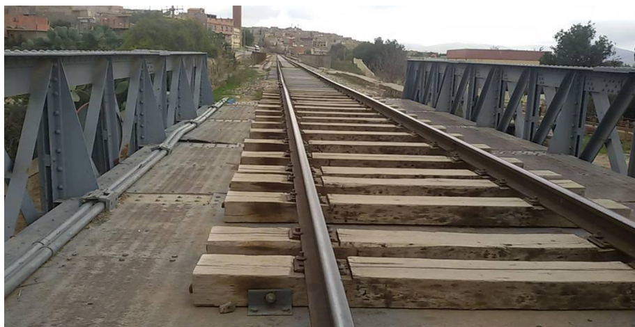
Photo.4.3 Tablier du pont
