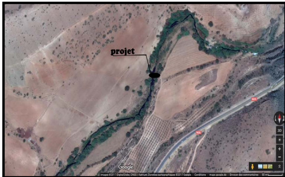
Figure 4.3 : vue de l'ouvrage au niveau d'Oued El Abbas
