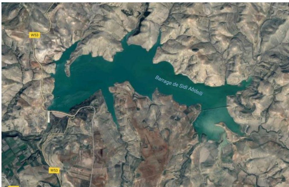
Photo IV.1: Vue par satellite « barrage Sidi Abdelli »
