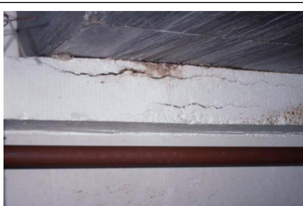
Photo 1.2 : Poutre support de réservoir (Taché, et al., 2003).
