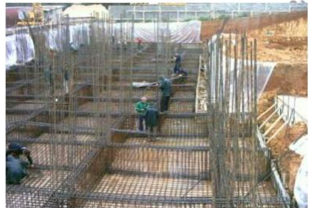
Figure 122: système de ferrailage radier nervuré 122
