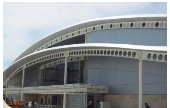
Figure128 : poutres alvéolaires courbées Limassol Sports Hall, Cyprus. 124
