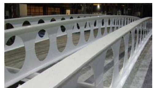
Figure129 : poutres alvéolaires type IPE. 124
