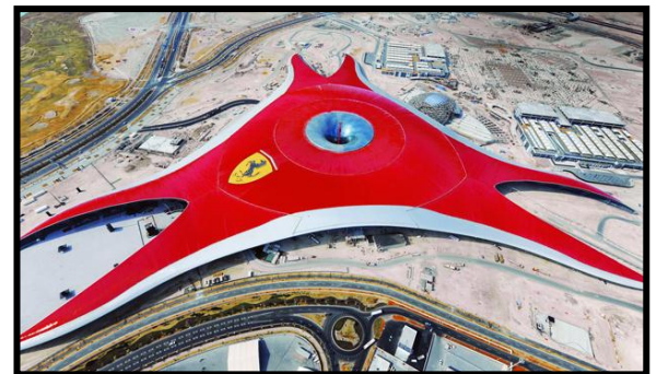
Figure 136 : vue aérienne Ferrari world Abu Dhabi. 131
