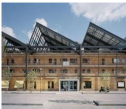
Figure7 : le centre de Pompidou
