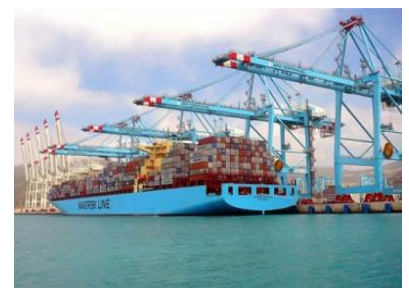
Figure72 : les grues d'accostage 89
