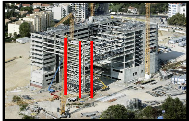
Figure 28 : les trois noyaux Figure 29 : un bâtiment en cours de en béton. 49 Réalisation 49
