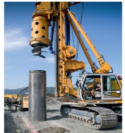
Figure 120 : Exemple de réalisation de pieux dans un chantier. 120
