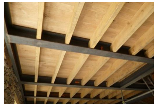
Figure13 : plancher en bois posé sur des poutres en acier 29
