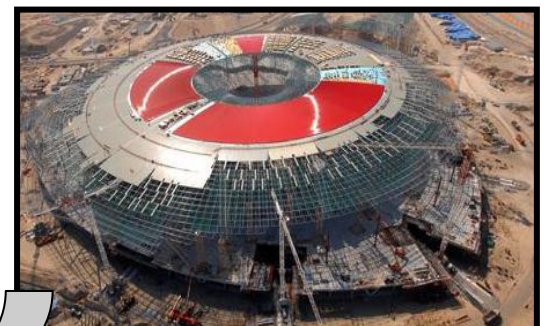
Figure 137 : Ferrari world Abu Dhabi en cours de construction. 131
