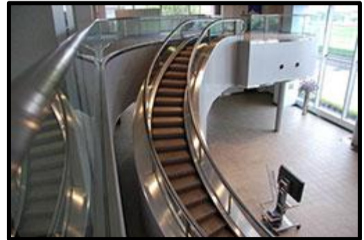
Figure144 : Escalier en spirale installé à l'entrée principale de Mitsubishi Electric Inazawa Works
