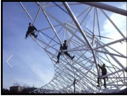
Figure 135 : les barres sous forme des arcs Tubulaires.
