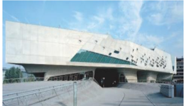
Figure30 : façade de Centre des Sciences Phaeno. 50
