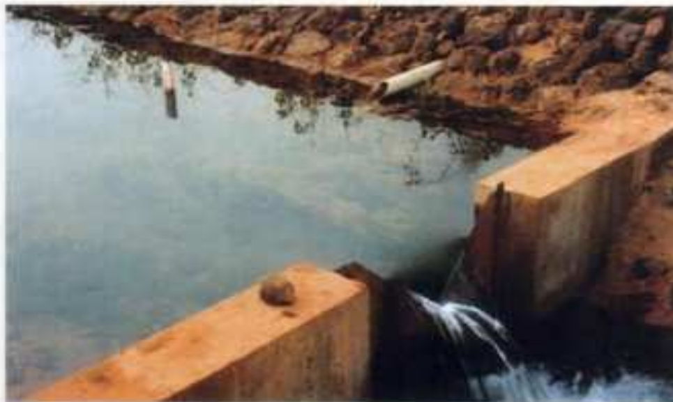
Figure 4.5 : Déversoir triangulaire (Antoine et al, 1992)
