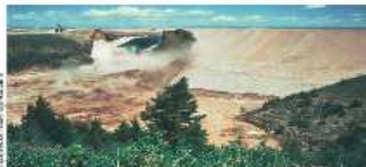
Figure 3.2 : Rupture de barrage de Teton (Bouhlali, 2006)
