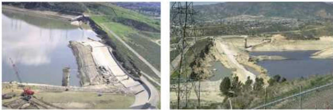
Figure 3.3 : Rupture du barrage San Fernando (Schleiss et Pougatsch, 2011)
