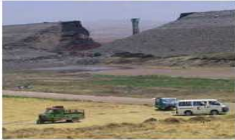
Figure 3.4 : Barrage de Zeyzoun après sa rupture (Schleiss et Pougatsch, 2011)
