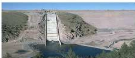
Figure 3.1 : Barrage de Teton (USA) avant rupture (Bouhlali, 2006)
