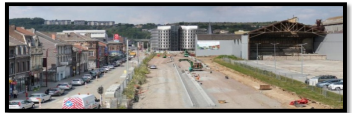
Figure 45 Construction de nouvelle voirie –chantier -
