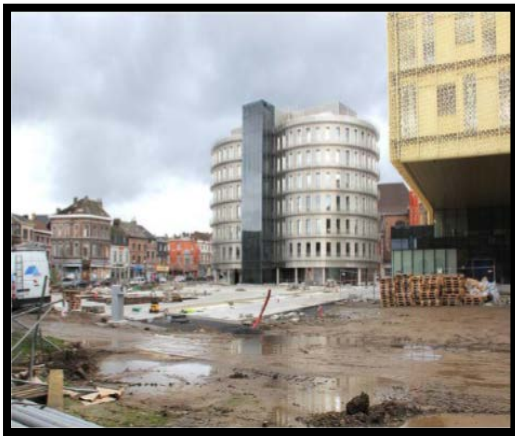
Figure 37 cité administratif chantier
