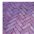
Pavés vieillis posés à chant
