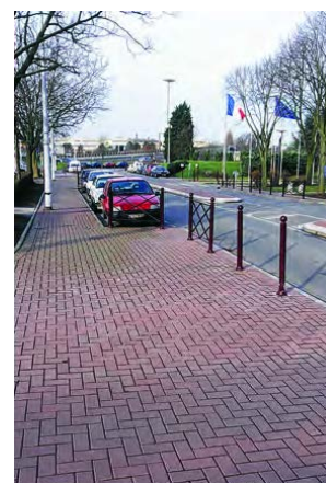
Pavés vieillis posés à chant
