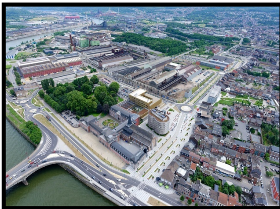
Figure 41 vue aérienne sur l'ensemble d'équipements
