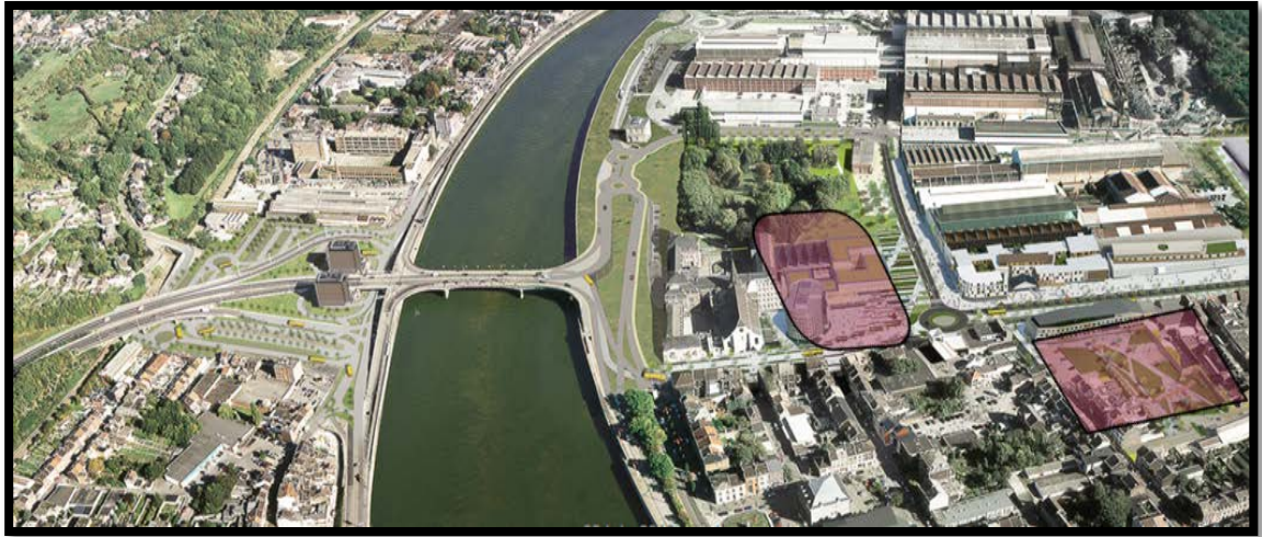
Figure 35 Emplacement de nouveaux équipements
