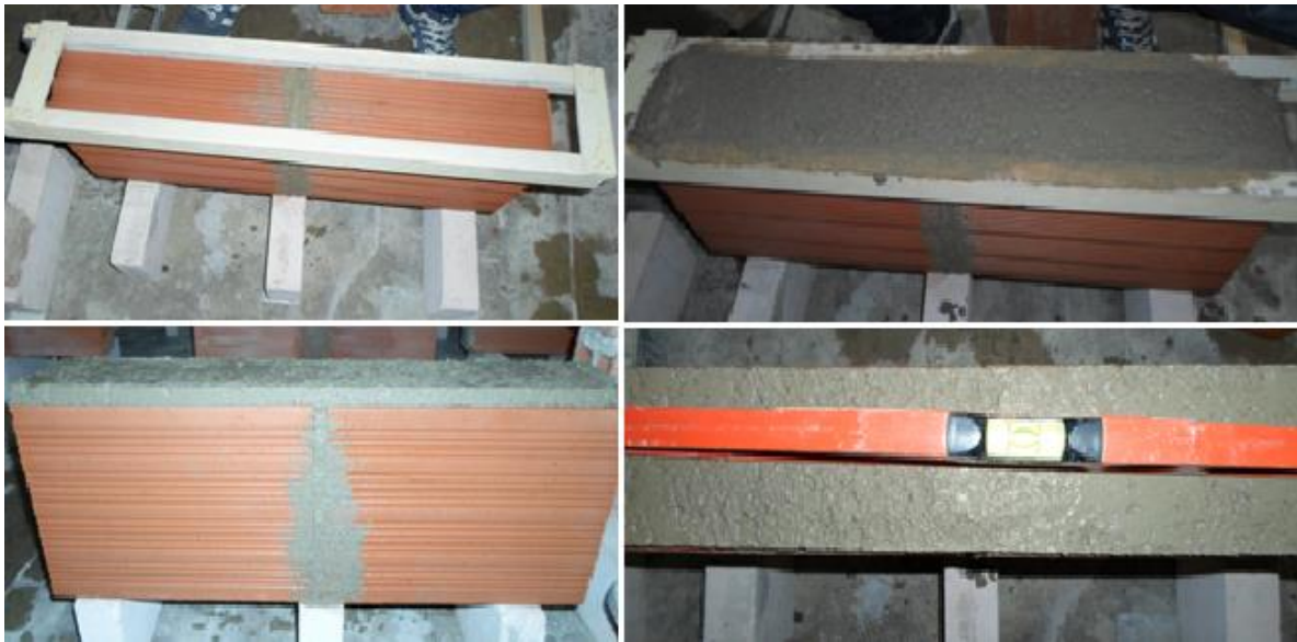
Figure 3.25: Pose du joint horizontal (photos prises par les auteurs).
