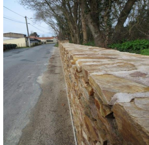
Figure 1.9: Mur en moellons de pierres [www.batisevre.fr]
