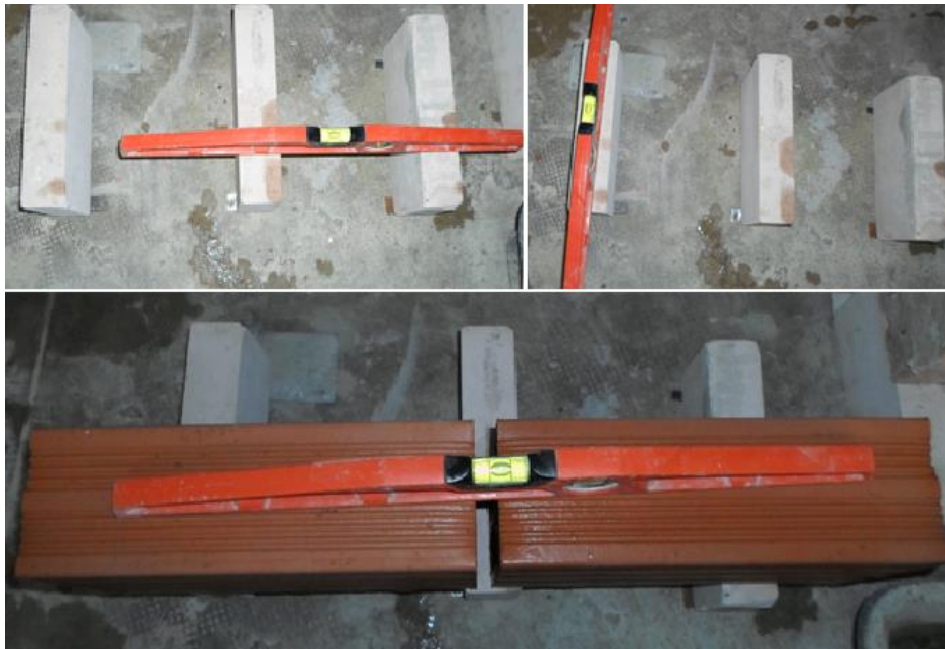
Figure 3.22: Préparation du support en assurant sa planéité (photo prise par les auteurs).
