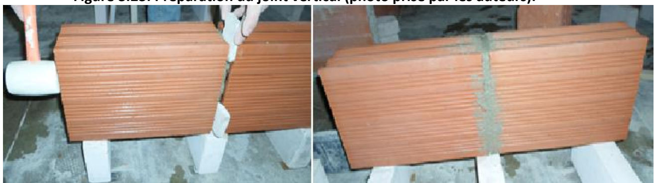
Figure 3.24: Vérification de l'épaisseur du joint vertical et le remplissage de ce dernier (photo prise par les auteurs).
