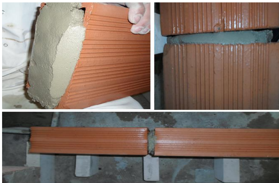
Figure 3.23: Préparation du joint vertical (photo prise par les auteurs).
