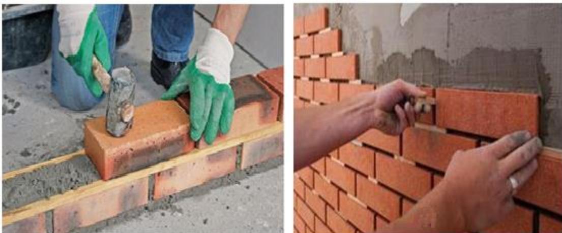
Figure 1.3: maçonnerie en briques pleines [www.systemed.fr]
