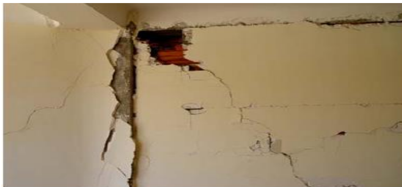
Figure 2.8: Destruction de l'extrémité du panneau du fait de la compression de la diagonale qui se forme dans le mur DAVIDOVICI 2003]
