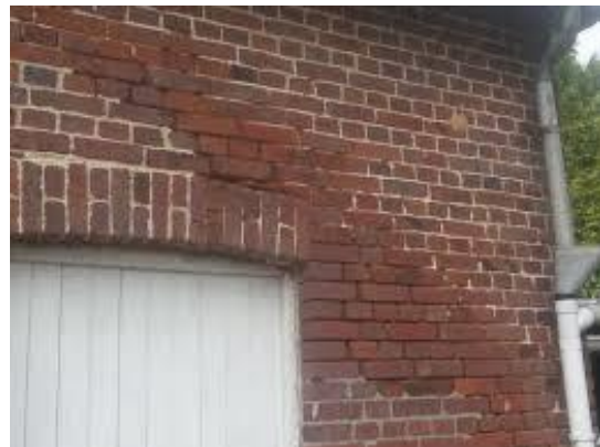
Figure 1.13: Dislocation des briques [ www.bricoleurdudimanche.com ]
