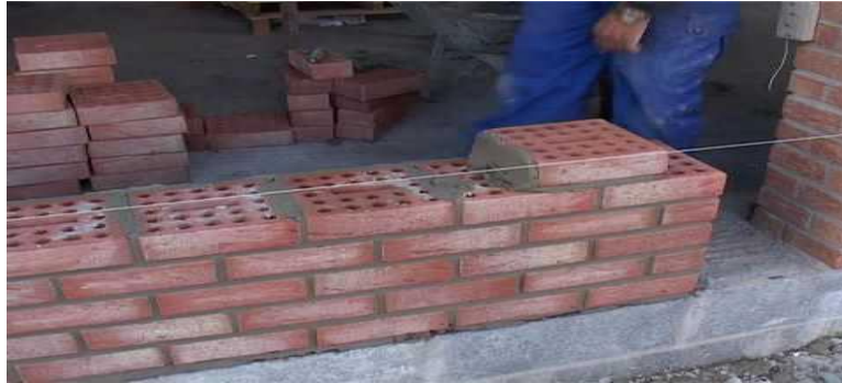
Figure 1.4: Maçonnerie en briques perforées [mur.ooreka.fr]
