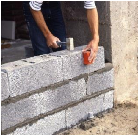
Figure 1.7: Maçonnerie en bloc d'agglomérés de béton [www.maisonbrico.com]
