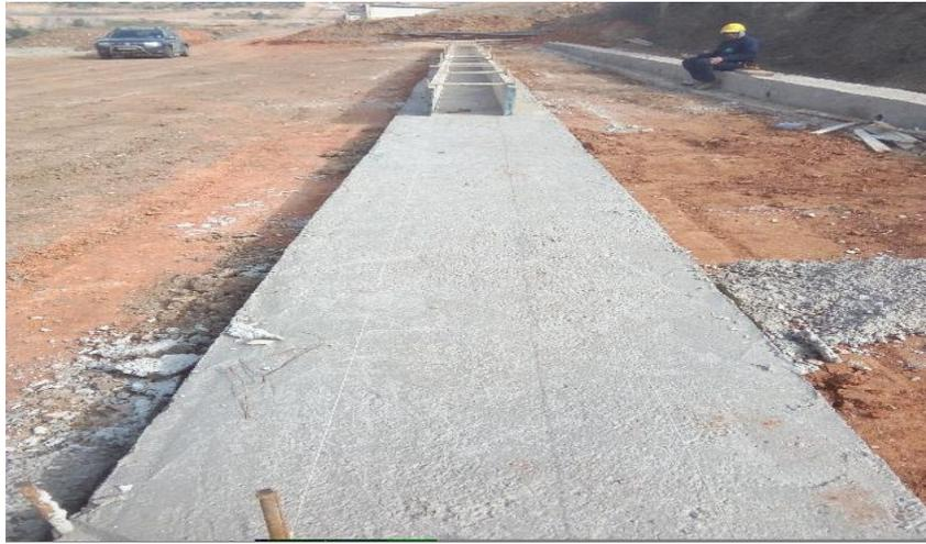
Photo 19 : Pose du béton de propreté
