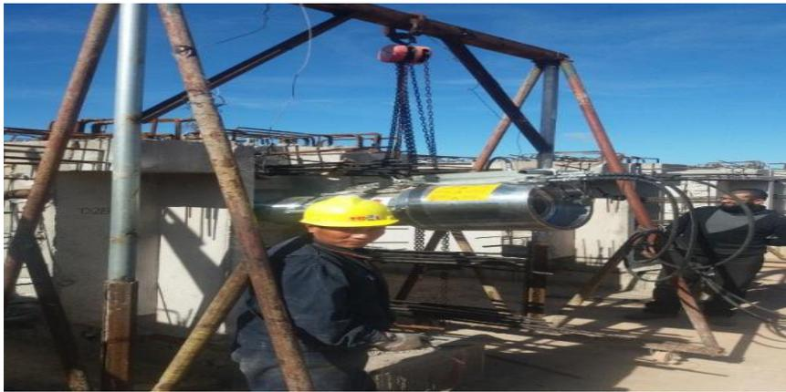
Photo 28 : Mise en tension des câbles de précontrainte
