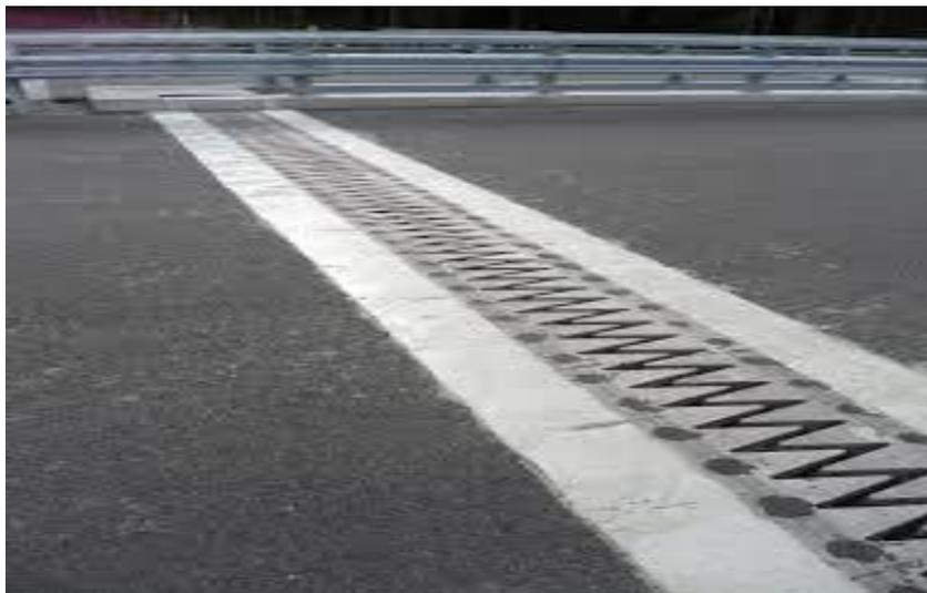
Photo 32 : Pose des joints de chaussée.
