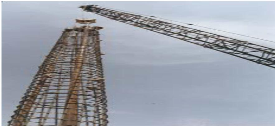
Photo 04 : Mise en place du ferrailage
