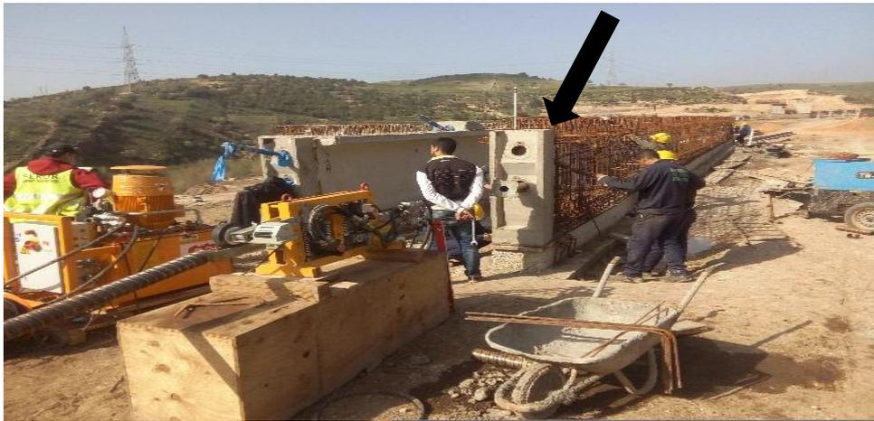
Photo 23 : Pose des abouts de poutre et passage des gaines
