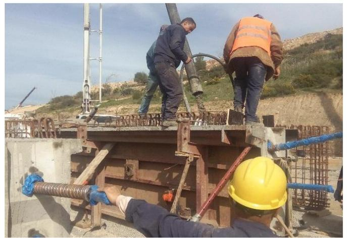
Photo 26 : Coulage de la poutre précontrainte
