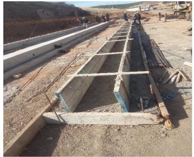
Photo 20 : Réalisation du socle de poutre
