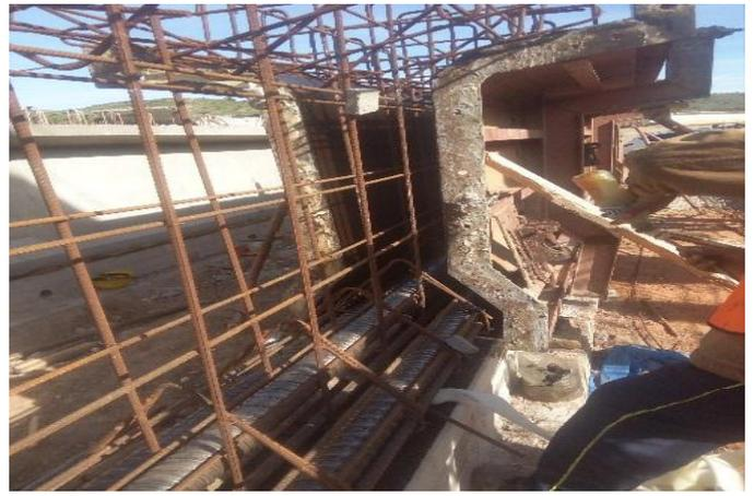
Photo 25 : Pose du coffrage de la poutre précontrainte
