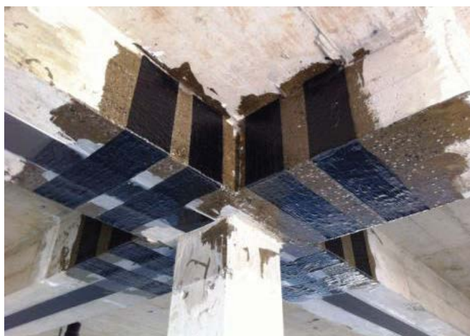
(b) Renforcement d'une poutre par collage de TFC
