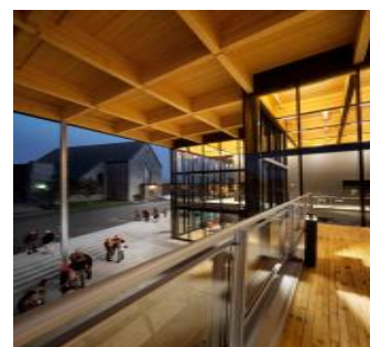
Figure 40. Toiture en caisson de bois lamellé collé
