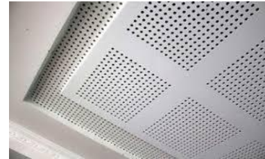
Figure 8. Plafond en plâtre
