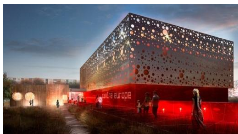
Figure 11. la nouvelle salle de spectacle à colmar. L'effet de l'éclairagee
