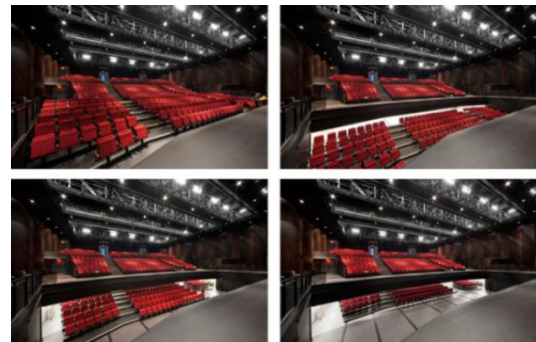
Figure 41. Plateforme sur élévateurs synchronisés
