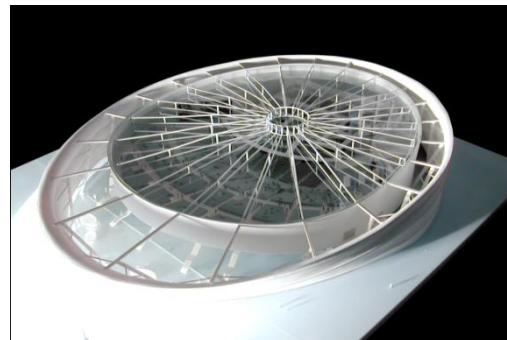
Figure 51. La structure de la membrane
