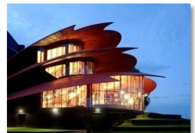
Figure 44. Hans Otto Theater Potsdam Dans cet exemple l'architecte à choisi des coquilles en bois rouge pour la couverture du toit
