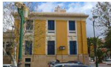
Figure 26. Façade latérale de la grande poste
