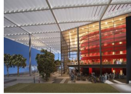
Figure 34. Utilisation du verre pour la façade
