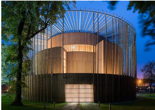
Figure 34. ossature extérieure du théâtre du château d'Hardelot
