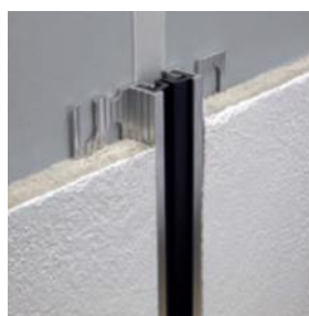
Figure 18. schéma du couvre joint pour mur
