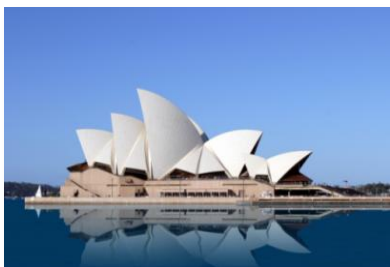
Figure 46. l'opéra de Sidney les coques sont en béton armé recouvert de tuiles miroitantes en céramique.
