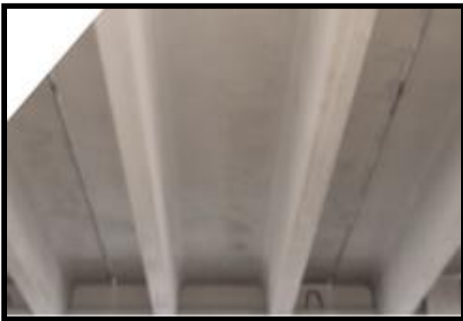
Figure 66: Résultat du plancher alvéolé
