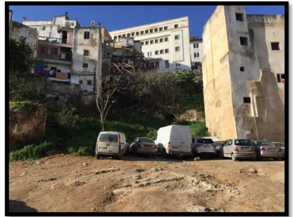
Figure 45: Vue depuis le sud sur le terrain
