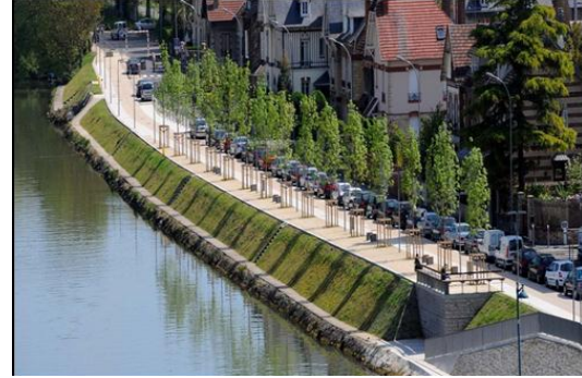
Figure 38: traitement des talus
