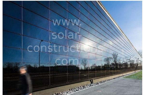
Figure151 façade solaire, des façades avec des vitres photovoltaïques, Murs photovoltaïques, revitaliser une façade avec l'énergie solaire
