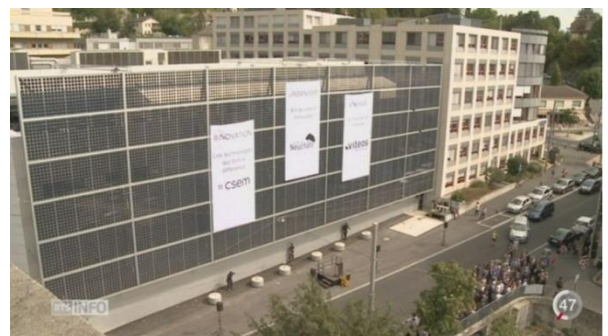
Figure156 Une façade photovoltaïque de plus de 600m carré
