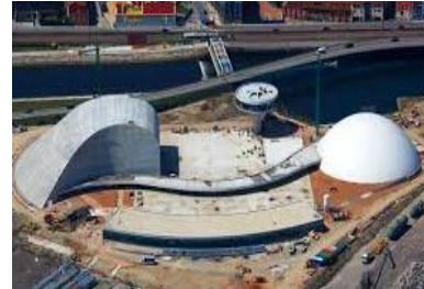
Figure 35 : photo de l'extérieur
