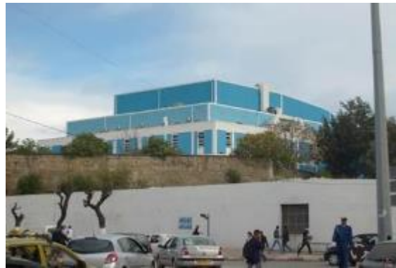
Figure47 : photo de l'extérieur
