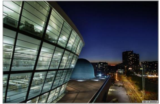
Figure26 : la bibliothèque de l'extérieur
