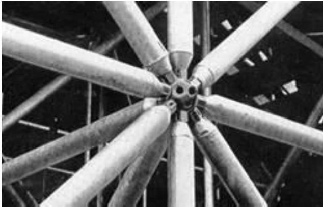
Figure 109: Buckminster Fuller détail d'assemblage d'une structure réticulée. Représentation de la notion d'équilibre des corps
