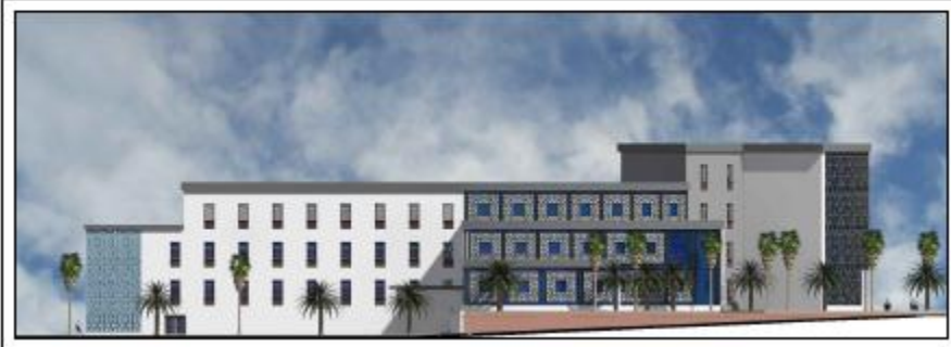
Façade Est bloc enseignement et recherche
