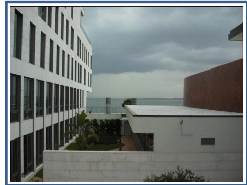
Figure 43 : Vue de l'intérieur de l'EMSA (Source : Revue CROSS)
