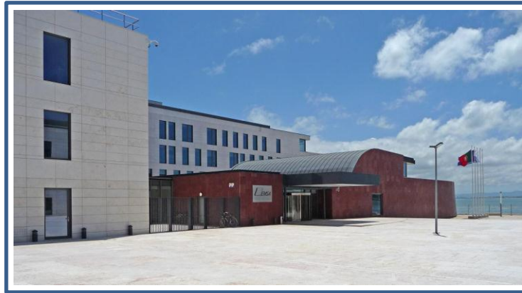
Figure 38 : Façade principale de l'EMSA (Source : Revue CROSS)
