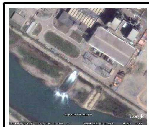
Figure 99 : rejet 3 de la centrale thermique électrique CTE.
