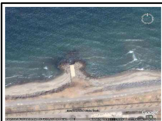
Figure 98 : Rejet 6 du canal de rejet du complexe des matières plastiques (CPIK).
