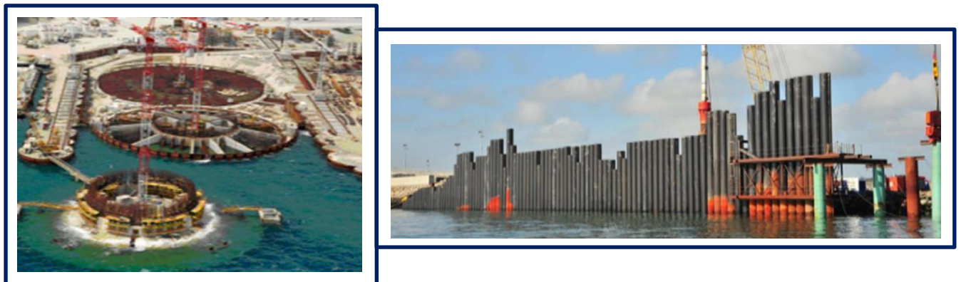
Figure 117: Terrassement avec rideaux de palplanches (Source : www.Terrassement avec rideaux de palplanche.com )
