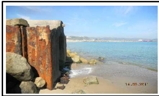
Figure 97: Rejet 4 du canal de rejet de la direction Régionale de la zone industrielle
