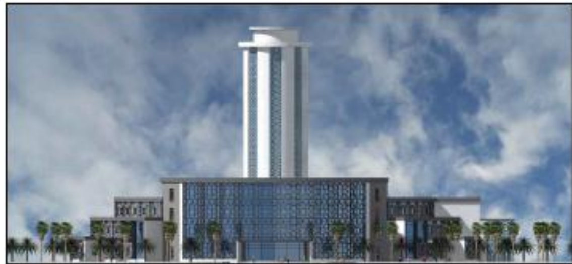
Façade principale bloc enseignement et recherche
