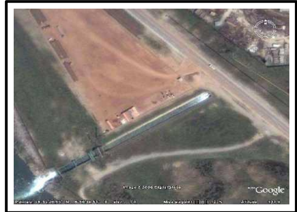
Figure 96 : Rejet 5 du canal de rejet du complexe du gaz naturel liquéfié GNL
