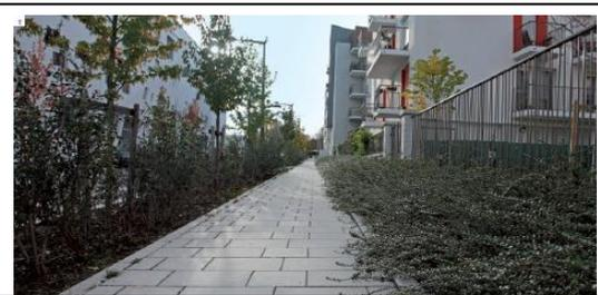
Figure 42 : pavées en béton gris ; usage de parvis pour les édifices.
