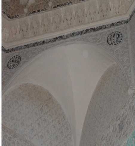
(الصورة رقم 21): صورة لحنية ركنية من داخل ضريح سيدي براهيم المصمودي تحمل كتابات
